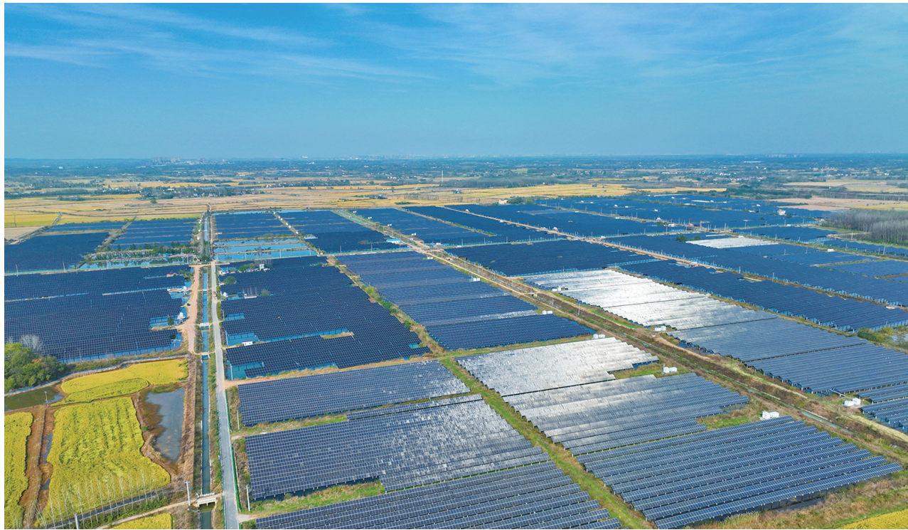
合肥光伏电站航拍图
