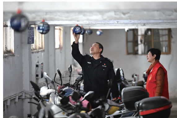
3月1日,合肥市庐阳区双岗街道虹桥社区的党员志愿者与物业工作人员在辖区开展“飞线整治不松懈,消除隐患保平安”隐患排查整治。图为工作人员对电动自行车临时充电区自动灭火球进行检查。记者 黄洋洋/图
