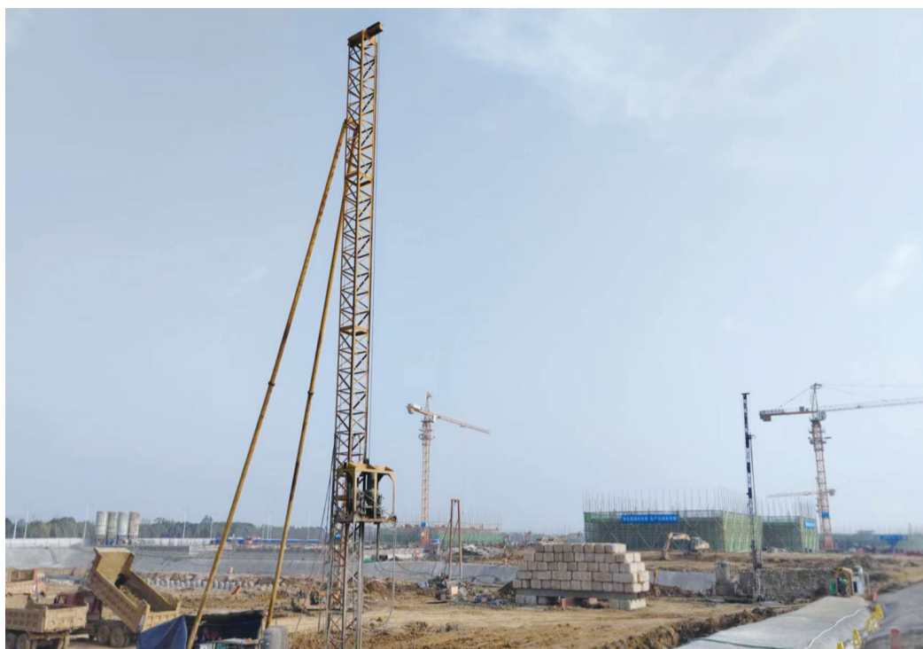
安庆市双生谷项目建设现场
