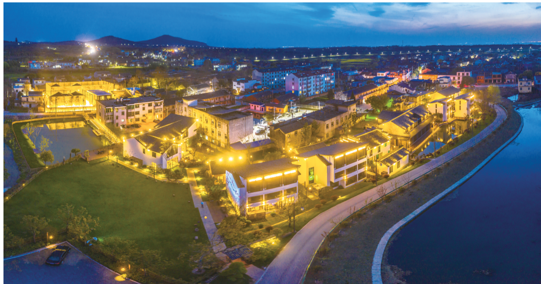
长临河镇六家畝民宿区
