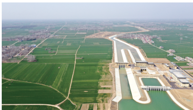
位于亳州市谯城区龙扬镇境内的龙德泵站是引江济淮工程7级提水泵站,江水北送西淝河线上的第5级泵站,也是安徽省境内的最后一级提水泵站
