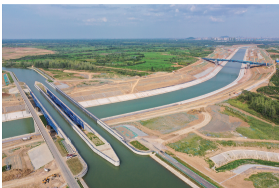
2022年9月6日,世界最大跨度钢渡槽——引江济淮淮河总干渠钢渡槽首次通航
