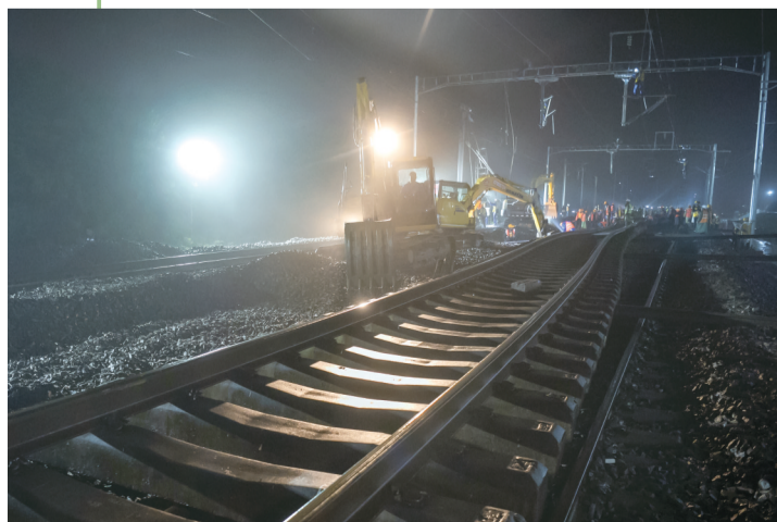
2019年12月24日,引江济淮宁西铁路改建工程现场
