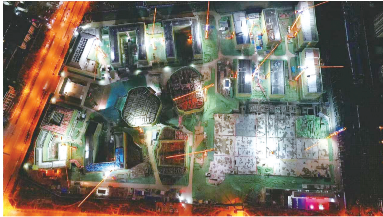
挑灯夜战的合肥一中东校区建设工地
