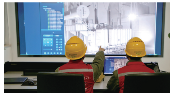
12月21日清晨6点,合肥供电公司变电运维中心员工在220千伏植物园变电站,使用红外测温仪并辅助智能机器人,对全站设备进行特巡工作。入冬以来,合肥供电公司积极运用先进技术手段,对全市输变电网络进行“立体式”巡检。截至目前,已累计完成合肥地区253座变电站的专项检查和隐患消缺工作。 ■ 李岩
