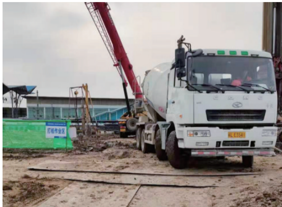
宿州火车站站前广场改造项目
