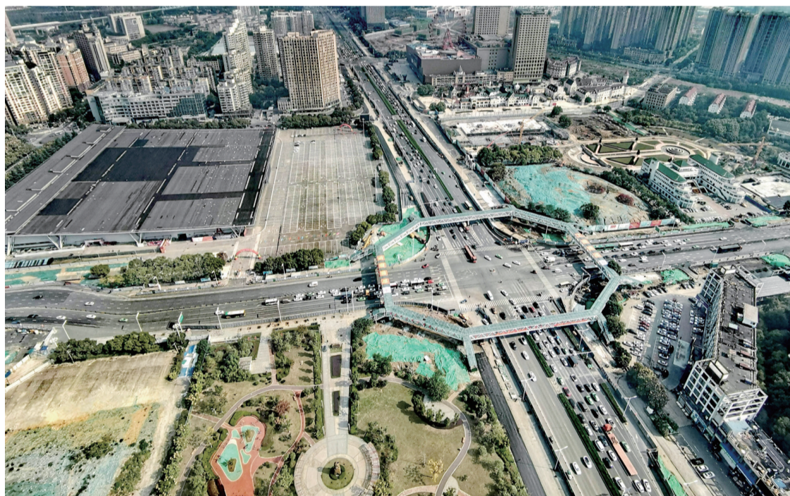
10月26日上午,伴随合肥市民14年的金寨路与繁华大道人行天桥(也称明珠广场人行天桥)正式开始拆除。
