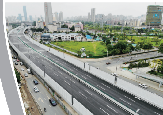
南二环和宁国路节点工程
