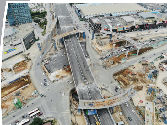
南二环和宿松路节点工程
