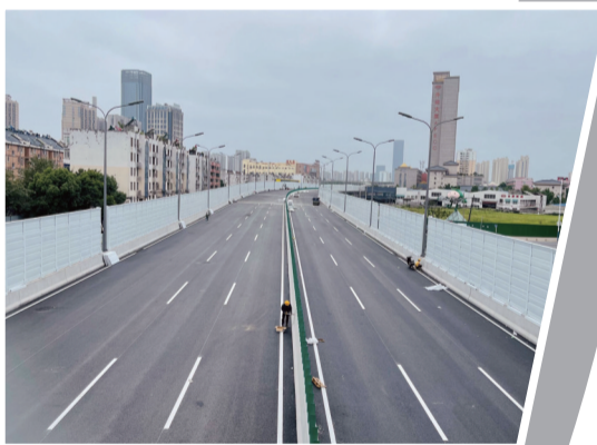
南二环和宁国路节点工程隔音屏障已经完成安装
