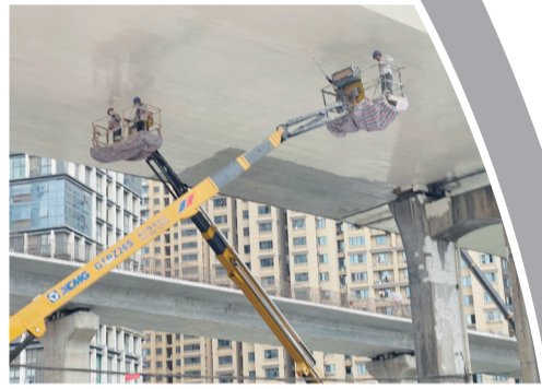
工人们正在给主线桥桥体进行粉刷
