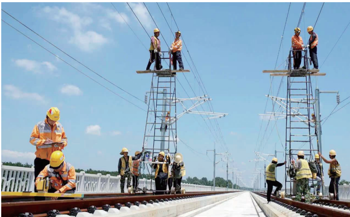
图为竣工验收现场
