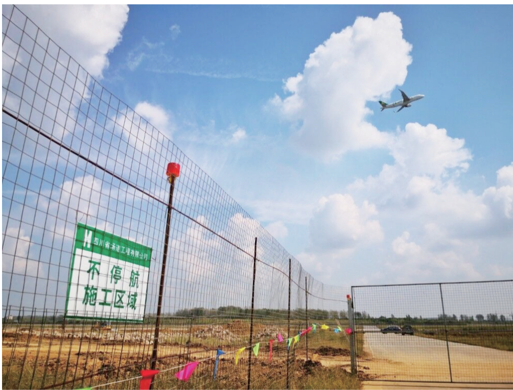
正在改扩建的新桥机场停机坪
