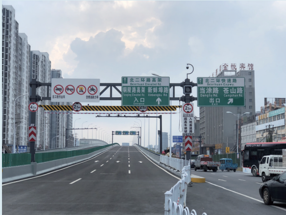
北二环主线高架桥
