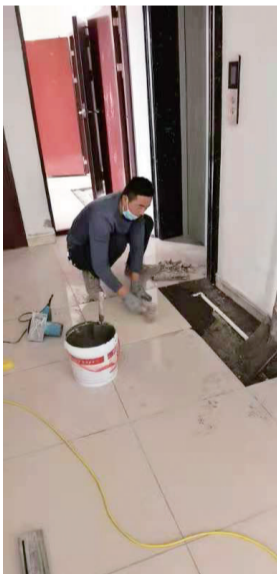
为居民解决水管爆裂维修问题
