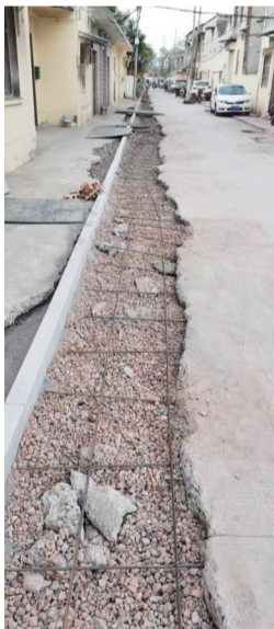
韩池孜社区为辖区维修道路
