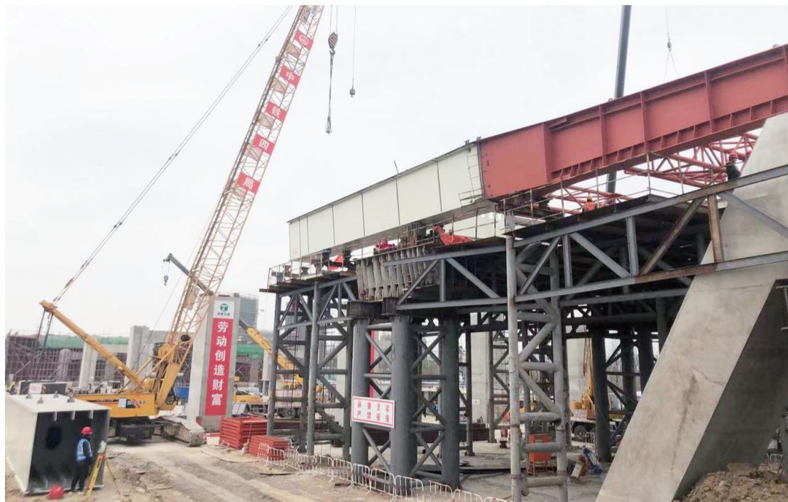
合肥畅通二环(合武铁路-当涂路)工程建设现场
