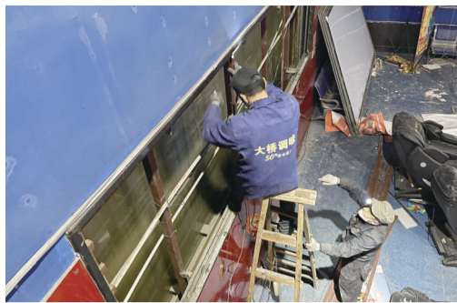
工人们正在对解放电影院内的附属物进行拆除
