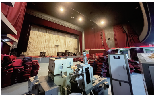
电影院内的一些放映设备已经拆下
