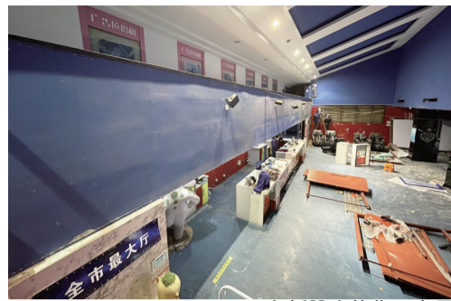
正在拆除中的售票大厅
