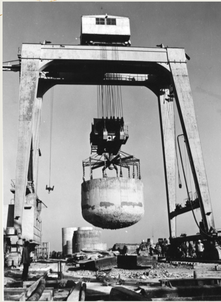
正在建设的响洪甸大坝
