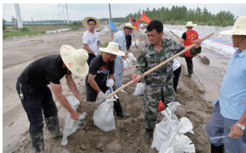
江洲镇柳洲村村支书洪棉雪(前右二)和村民、支援人员一起装沙袋,加固堤坝。
