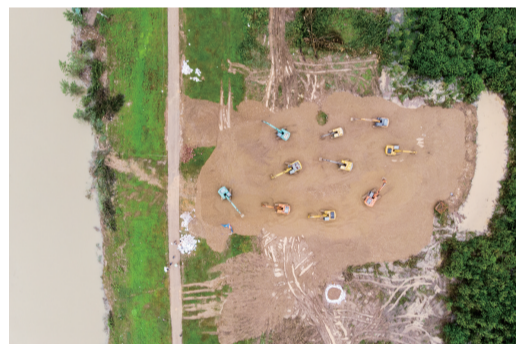
7月19日,在澧南镇邢家河渡口堤段,挖机在封堵管涌(无人机照片)。
