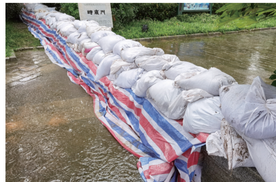
7月19日, 在合肥市雍门遗址石碑旁, 抢险人员筑起防洪墙, 防止洪水流入城内。 口记者 马启兵
