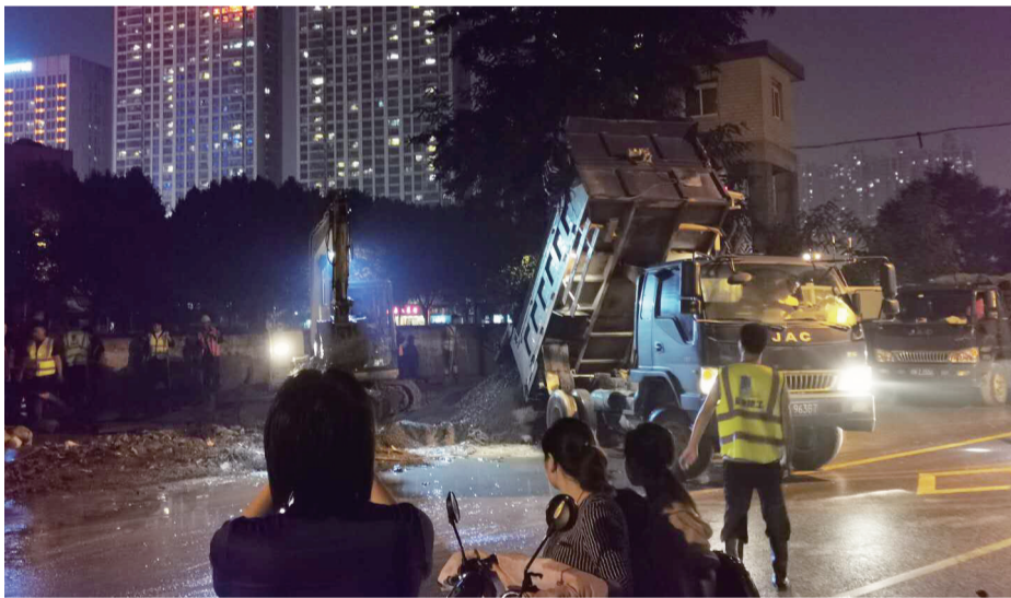
7月19日晚, 合肥市南淝河(滨河路与和平路交口段)河堤出现渗水, 工作人员紧张填埋抢险。 口记者 李尚辉
