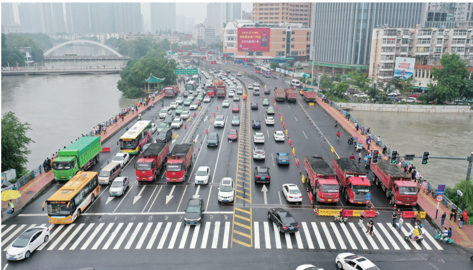
7月19日 15:40, 合肥长江路桥上停着数辆满载石子的重型卡车, 防止桥体浮动。 记者高斌
