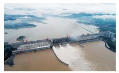
长江三峡枢纽开启泄洪深孔泄洪(7月2日摄,无人机照 片)。受强降雨影响,长江上游干流、乌江及三峡区间来水明 显增加,2日10时三峡水库入库流量达50000立方米/秒。根 据全国主要江河洪水编号规定,此次来水达到洪水编号标 准,"长江2020年第1号洪水"在长江上游形成。□ 新华社发
