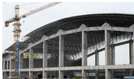
近日,合安高铁肥西站主体建筑及站前广场已经复工,目前正在加紧施工,有望年底前建成投用。合安高铁是国家“八纵八横”铁路网规划京九高铁的重要组成部分,肥西站则是沿途重要的新设站点。新建的肥西站总占地面积20149平方米,其中主体房屋建筑7995平方米。
