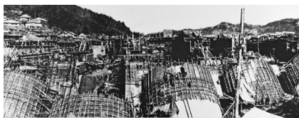
1952年1月，被誉为“新中国第一坝”的佛子岭水库工程开工建设
