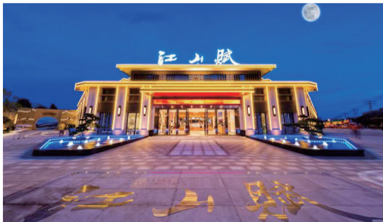
江山赋示范区实景
