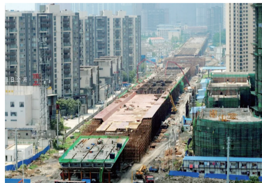
建设中的铜陵路高架桥
