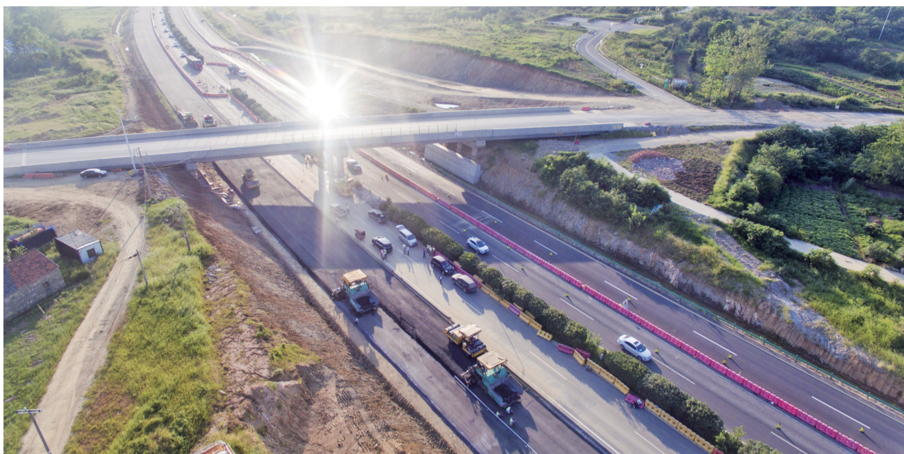
合宁高速改扩建工程
