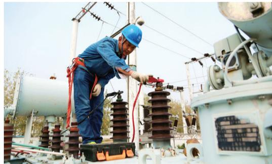
10月17日,长丰供电公司检修试验班人员在35千伏陶楼变电站对该变电站的1号主变进行预防性试验,保障设备正常供电。检修人员分别对1号主变进行了直流电阻、绝缘电阻测试,介损测试,泄漏电流测试,有载开关特性试验等。
