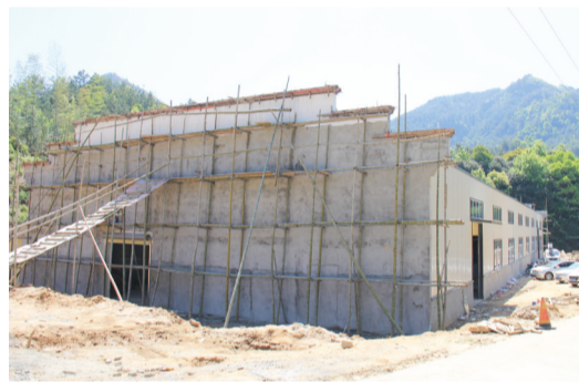
茶厂仍在建设中
