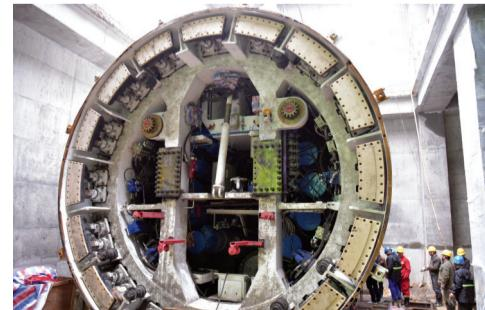
19日下午，记者来到位于合肥望江西路与长宁大道交口处的4号线长宁大道站采访，发现该线路的首台盾构机已经下井组装，调试完毕后，预计下月初正式始发。根据施工进展，首条单线隧道有望今年10月贯通，首条区间隧道有望明年6月贯通。
