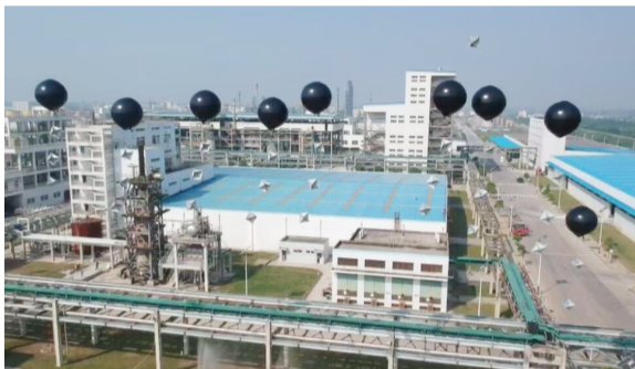
昨日上午,合肥循环经济示范园区防空警报声响起,合肥市9·18防空警报试鸣暨“合盾-2017”防护综合演练正式拉开。本次演练,参演人员200余人,动用各型车辆装备40余台,器材200件套,无人机五架。图为雷达干扰气球。
