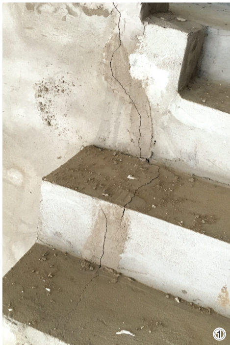
①楼梯的裂缝,已被修补 ②窗框建设过大,四边只 有用泡沫胶粘住
