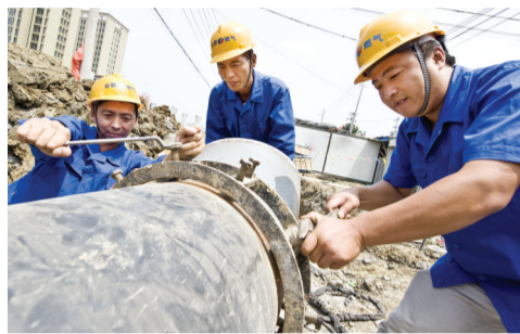
铸铁管网改造 消除隐患惠民利民
