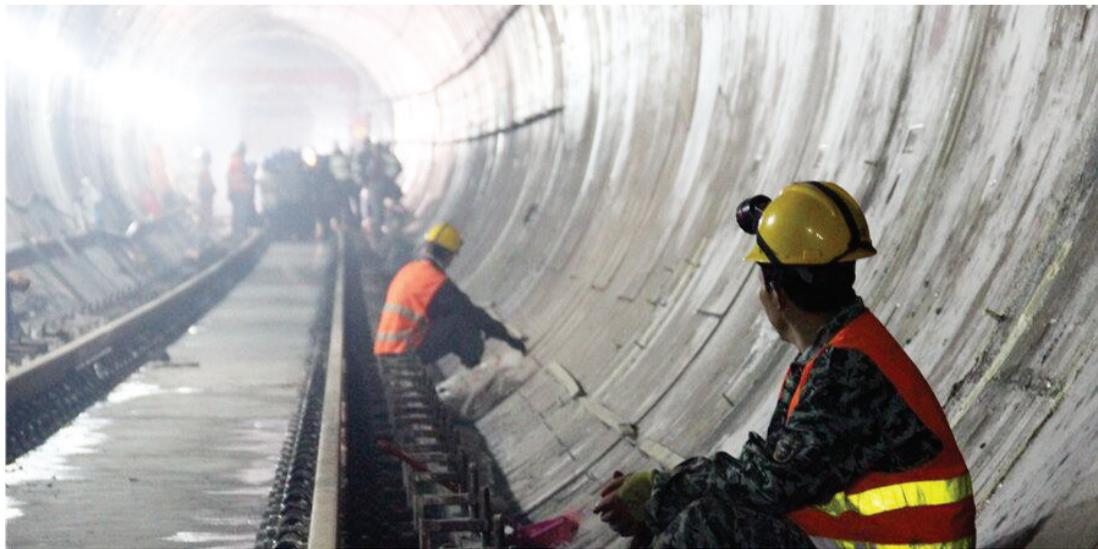
星报讯(陈晓明 记者 于彩丽 文/图) 市场星报、安徽财经网记者昨日从合肥市轨道交通1号线铺轨现场获悉,截至昨日,合肥轨道交通1号线已实现短轨接通,接下来将进行焊接通电等工作施工,预计5月1日实现全线长轨通,即地铁1号线列车可以在1号线全线调试。此外,1号线列车司机已经培训结束到岗,正在进行列车运行调试。
