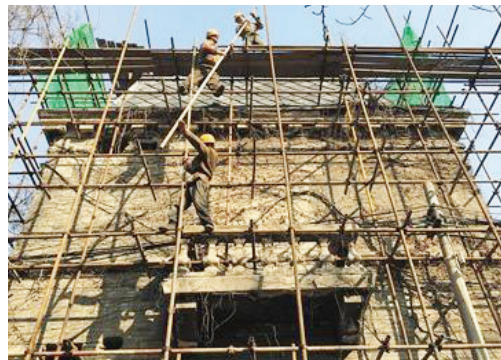
2日，朝内大街81号院正在施工。
