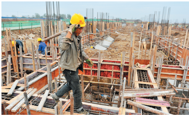
2号线“体检医院”施工现场
