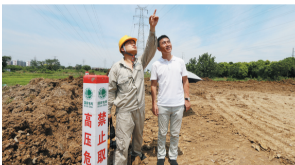
合肥供电公司员工正在高压线下对施工负责人进行电力设施保护宣传
