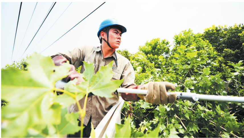
合肥供电公司员工正在进行线路通道内的树障清理工作
