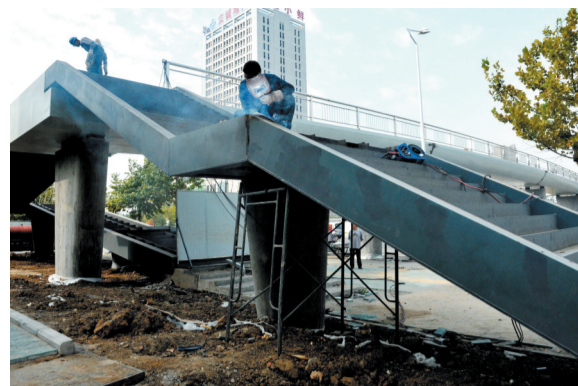
合肥火车站东南角新建一座人行过街天桥。日前,横跨翡翠路上的主桥及阶梯已搭建完毕,现场工人正在进行护栏的焊接,预计10月份市民就可以通行。 记者 倪路/图
