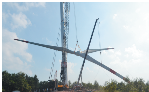
近日，肥西铭传乡莲花山风电项目首台风机装机完毕，预计10月初就可实现年发电量400万千瓦时。据悉，此次安装的风电机组，塔筒高度为85米，扇叶直径达到110米，是安徽省目前最大的风力发电机组。图为风机正在进行叶片安装。
