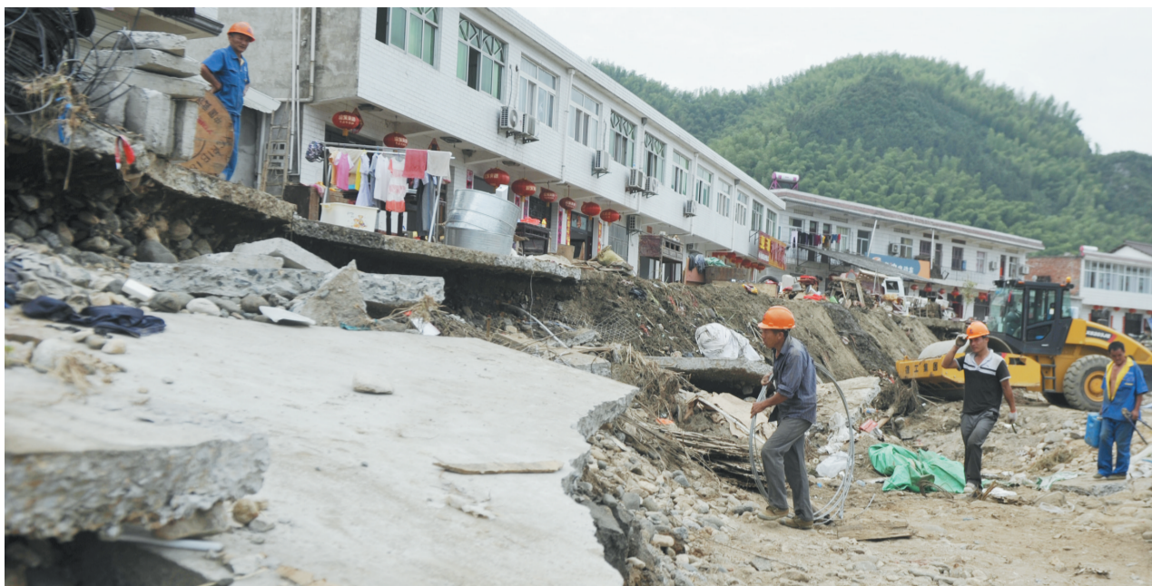
电力部门在诸佛庵镇抢修电缆
