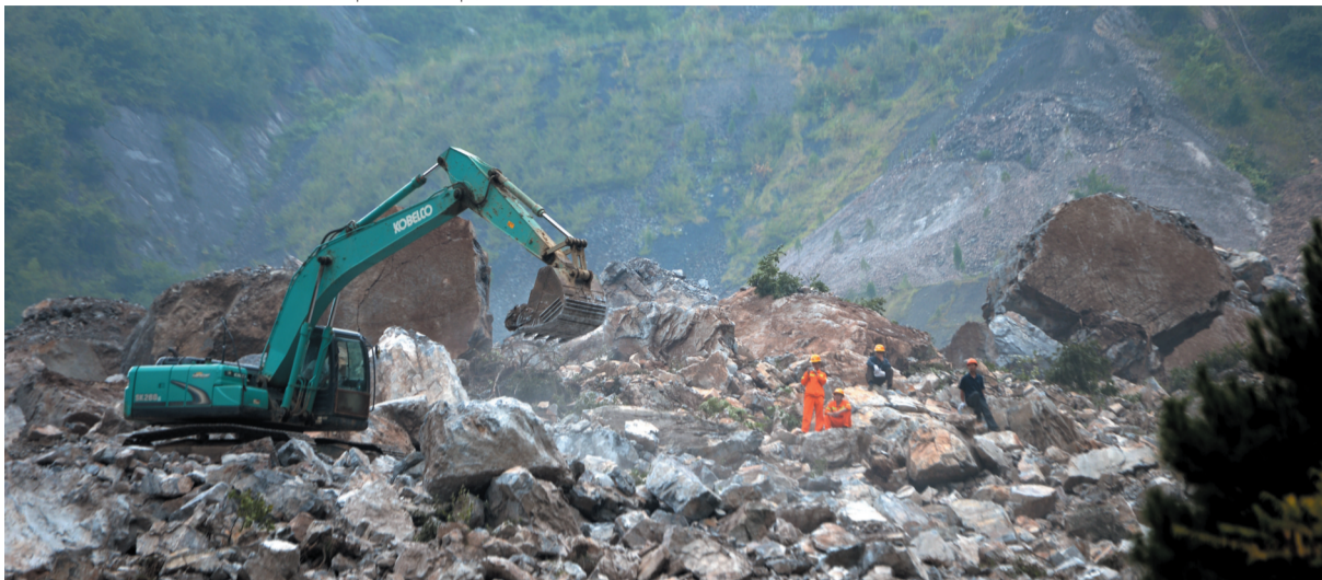
抢险人员在山体滑坡事故现场清理土石方
