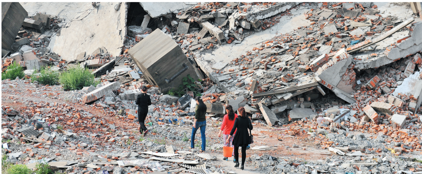
出行要从拆迁现场穿行，既危险又不方便
