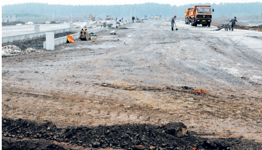
合肥望江西路再迈西延步伐。据悉,延伸部分(大龙山路——将军岭路)长约2.4公里,路幅宽60米,主线为双向8车道,将于8月底全面竣工通车。 记者 倪路/图
