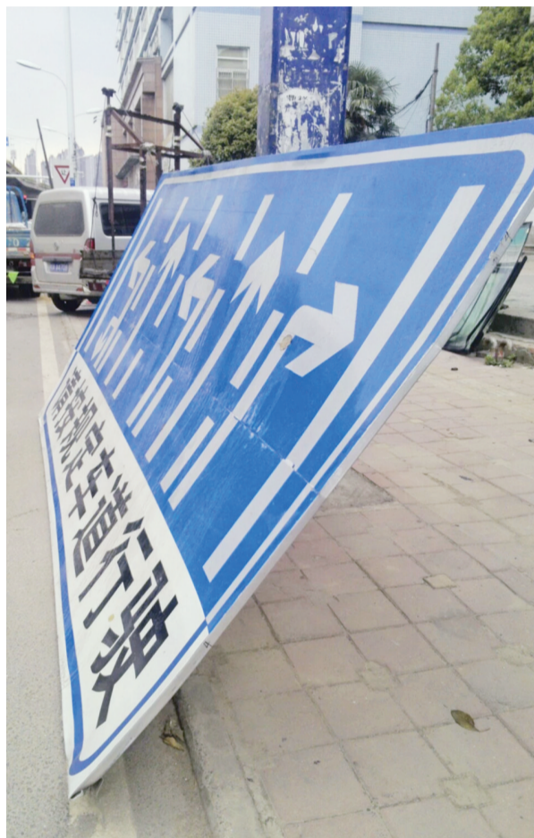
合裕路高架下一指示牌被大风吹落
