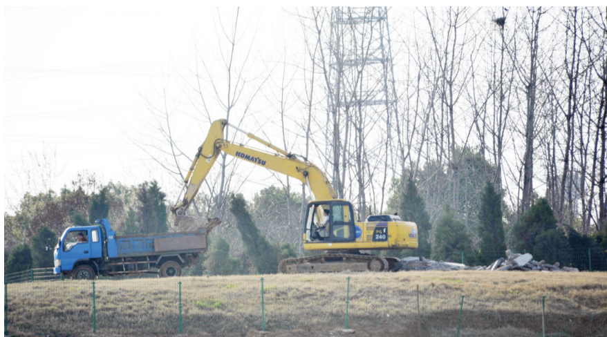
工程车辆对违规建筑物进行拆除
