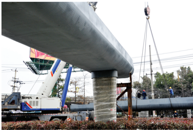
在合肥庐州大道与绕城高速交口南侧,一座新增的人行天桥正在搭建。昨日上午,记者现场看到天桥主桥即将合龙。该天桥建成后,周边居民在庐州大道穿行更加安全便捷。 记者 倪路/图
