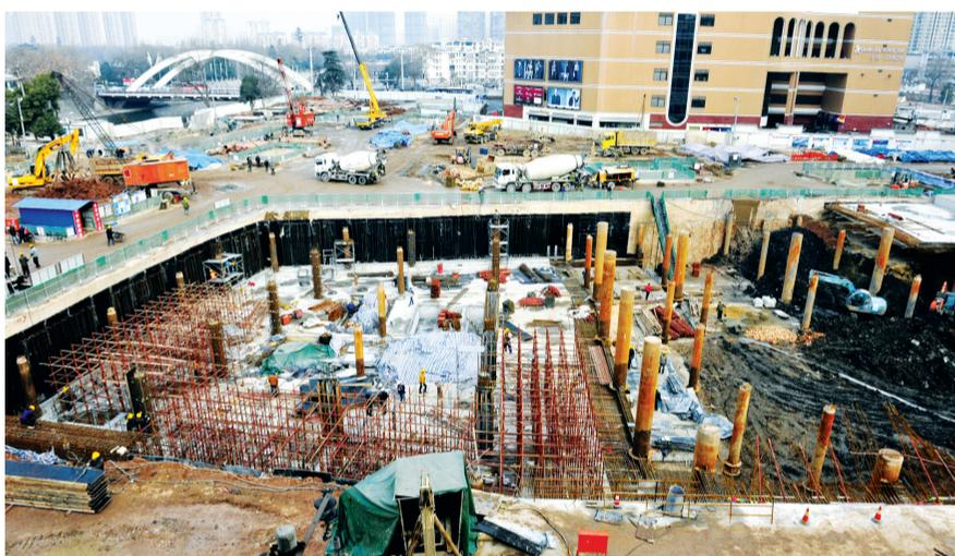
合肥轨道1号线大东门站主体完成八成,负一层和负二层主体结构已经完工,有望今年一季度结构封顶。据悉,轨道1号线和2号线的T字形换乘站,是整个1号线规模最大、车站基坑最深、周边建筑物最近、地质最为复杂的一个站点。
