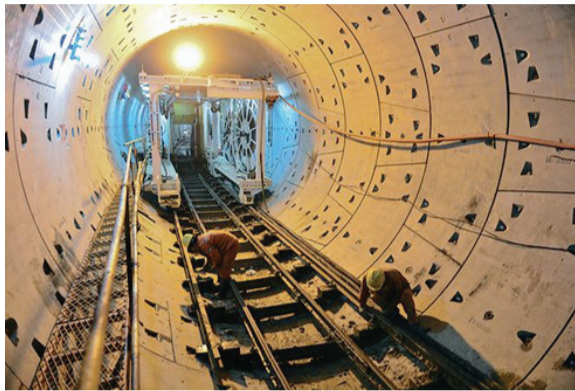
建设中的合肥地铁1号线(资料图片)
