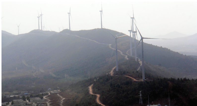
12月16日，芜湖首座风能发电站——华电福新无为万寨48MW风电场一期在无为县建成投运。该项目分三期建设，一期有24台风电发电柱，配套建设92基铁塔，预计年发电量1亿度，每年可节约标煤3.2万吨。刘彩霞 记者 王小雨 李青松 文/图
