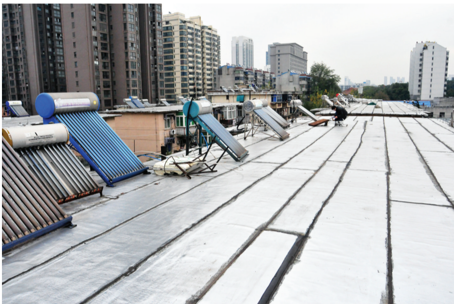
曙光新村楼顶改造后
