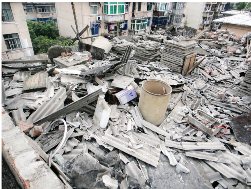
改造前的曙光新村楼顶
