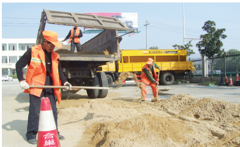
11月20日, 由合巢芜公路管理处、合巢芜高速路政大队、合肥高速交警六大队、芜湖高速交警三大队联合主办的“芜合高速2014年除雪铲冰应急演练”在合巢芜公路管理处大院内紧张有序地进行, 提前打响冬季高速平安保卫战。图为高速公路养护工人在清除“冰雪”。 秦宏斌 记者 张发平 陶理清 文/图
