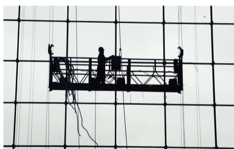
工人正在安装玻璃幕墙
