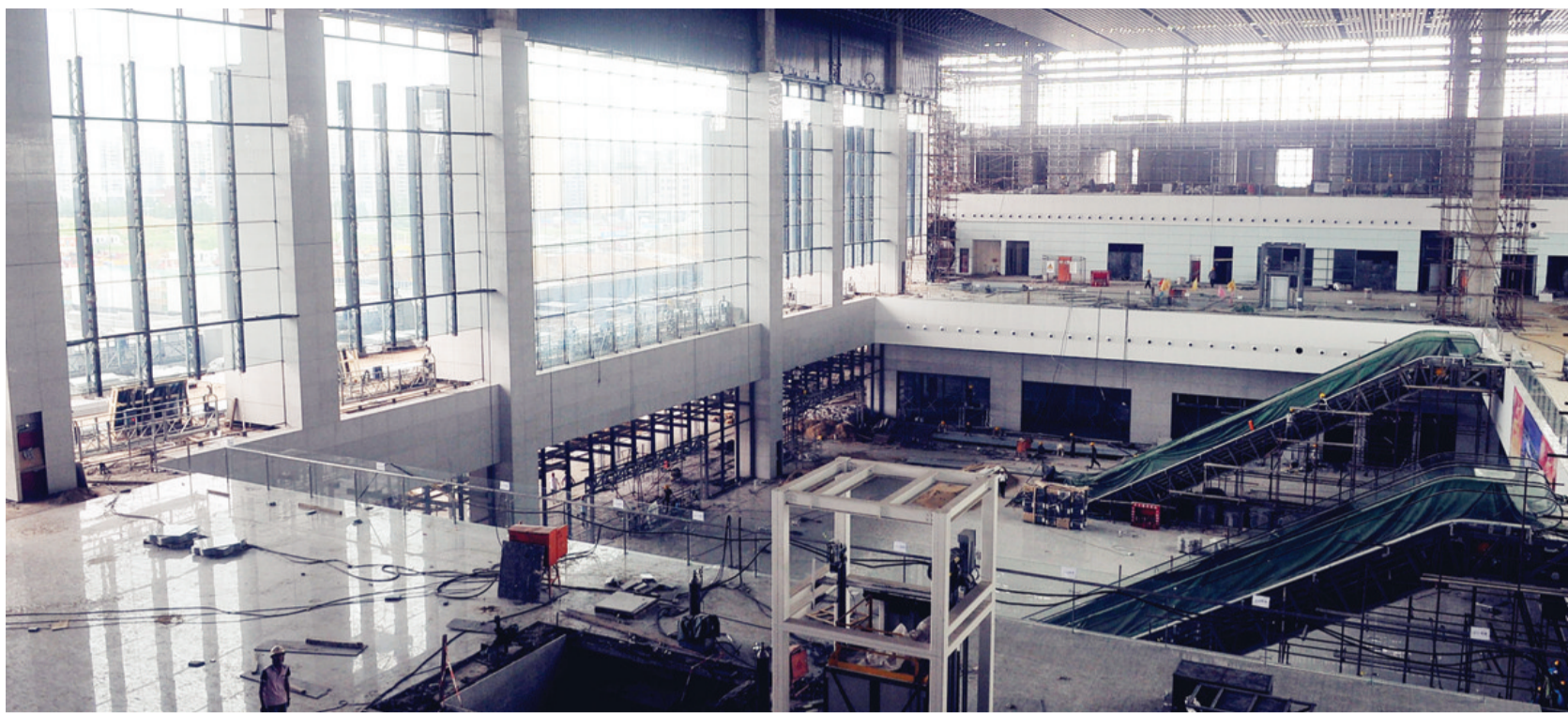
北广场进站大厅全貌
